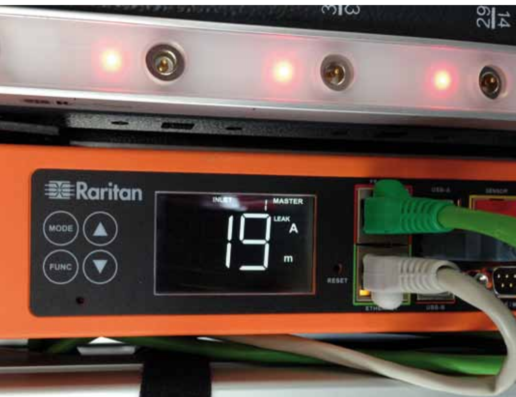
Differenzstrom messen: Eine intelligente Power Distribution Unit (iPDUs) misst direkt.
