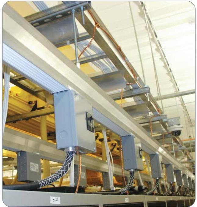
L'alimentation est possible en tout point de la canalisation, éliminant ainsi le recours aux panneaux de dérivation, aux longues sections de conduits et de câbles, et aux installations coûteuses.
